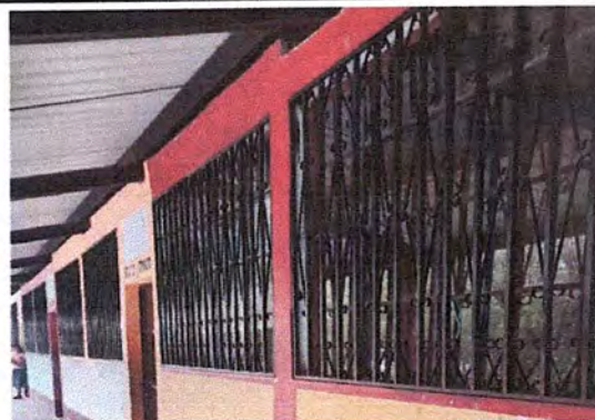
Foto 2: Pintados con anticorrosivo
