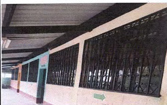
Foto 2: Vista de las aulas con balcones instalados.
