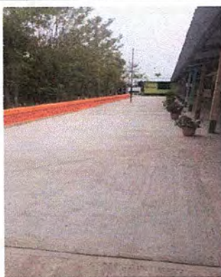
Foto 3: Losa de patio fundida por cuadros.
