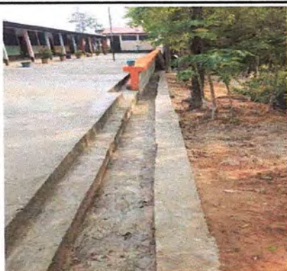
Foto 1: Lugar donde inicia la cuneta de concreto.
