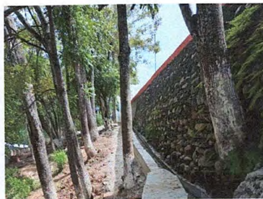
Foto 4: Lugar donde finaliza la cuneta de concreto.
