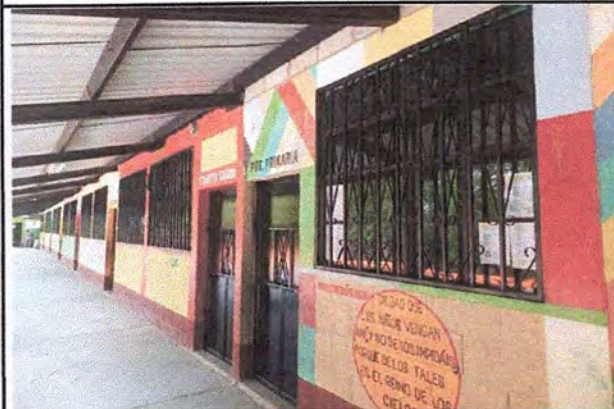
Foto 4: Finalización de la instalación.
