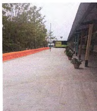
Foto 2: Vista de toda la losa de patio.
