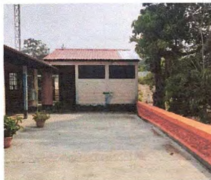
Foto 4: Instalacion de lamina finalizado.
