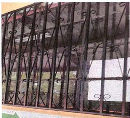
Foto 1: Mantenimiento de balcones finalizado.
