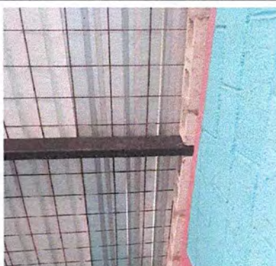
Foto 1: Lamina de techo instalado.
