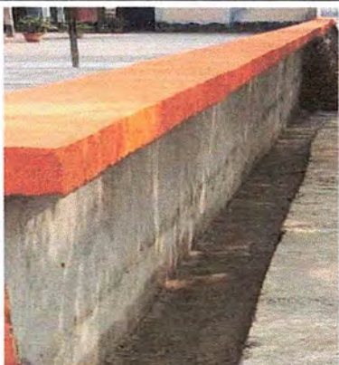
Foto 3: Muro Repellado
