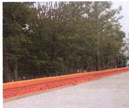
Foto 4: Vista del muro medianero.
