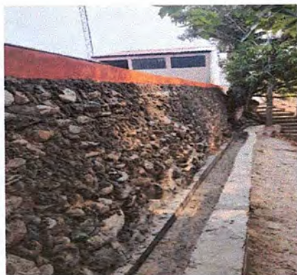
Foto 3: Cuneta debajo del muro de piedras.
